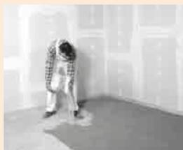
Les éléments sont ensuite remplis à l'aide des granules pour nid d'abeilles. Il est possible de marcher sur les éléments nid d'abeilles vides mais il reste préférable de commencer le remplissage côté porte du local et de se déplacer ainsi sur des éléments nid d'abeilles remplis.
