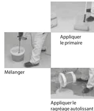
Si nécessaire, aplanir la surface avec une truelle ou un rouleau dentelé. Pour une épaisseur de 3 mm la surface est praticable au bout de 3 heures et peut être recouverte au bout de 24h.
