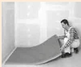
La plaque FERMACELL nid d'abeilles se pose en pleine surface. Une isolation phonique optimale est garantie, si la plaque FERMACELL nid d'abeilles est appliquée directement sur le plancher porteur. Le débord de carton des éléments nid d'abeilles permet le chevauchement d'un élément sur l'autre. Attention à s'assurer que toutes les alvéoles soient fermées de façon à ne pas laisser écouler latéralement de granules. La plaque nid d'abeilles peut être découpée au cutter.
