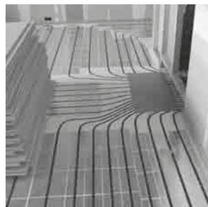
La présence éventuelle de vides plus importants, comme les faisceaux de distribution dans la zone du répartiteur par exemple, oblige à des dispositions particulières. En effet, dans ces zones, la chape FERMACELL risque de trouver une trop faible surface d'appui.
